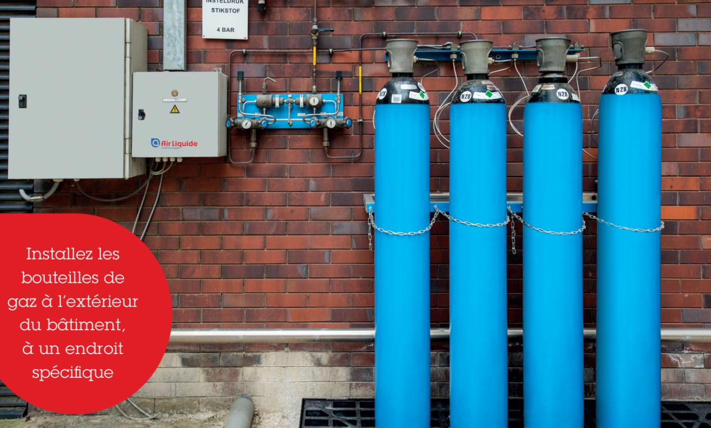
Installez les bouteilles de gaz à l'extérieur du bâtiment, à un endroit spécifique
